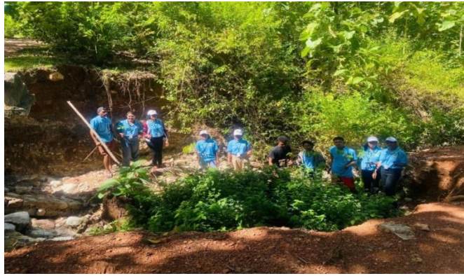
Gambar 3. Penghijauan di Lokasi Rawan Longsor
